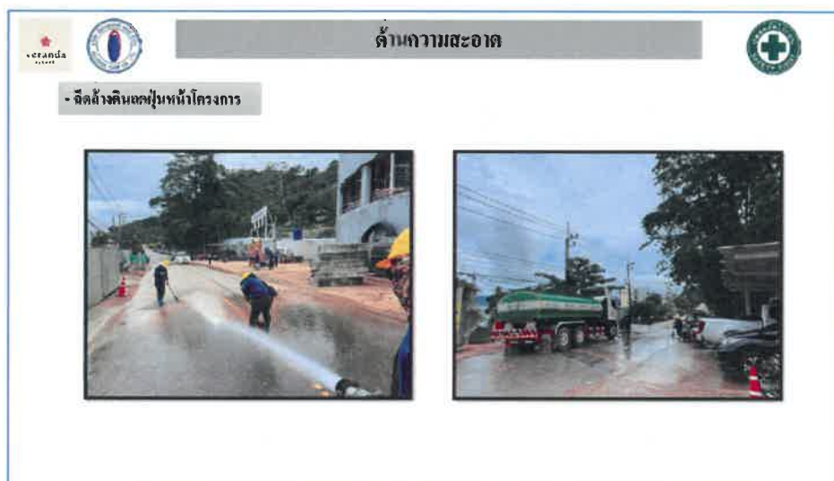
ภาพถ่ายที่ 2.1-6 จุดล้างล้อรถก่อนออกจากโครงการ การฉีดพรมน้ำ และล้างทำความสะอาดบริเวณทางเข้า-ออกโครงการ
