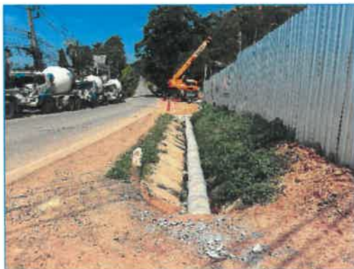
ภาพถ่ายที่ 2.1-2 การจัดทำท่อระบายน้ำด้านหน้าโครงการ
